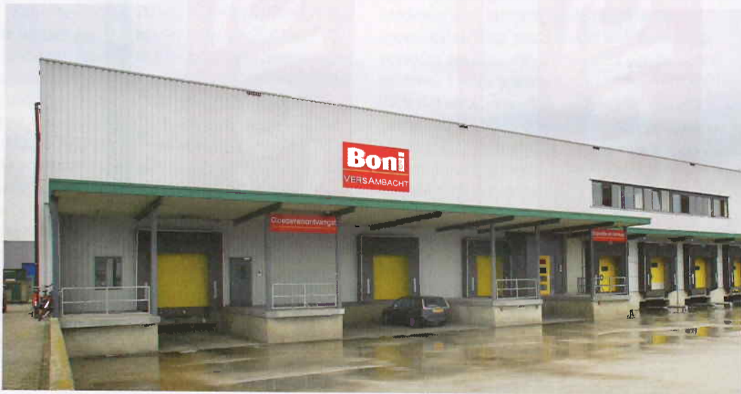
Boni Vers Ambacht is gevestigd tegenover het Boni-dc in Nijkerk. De supermarktketen kon het pand overnemen van de buurman. Momenteel is een kwart van de oppervlakte in gebruik.
